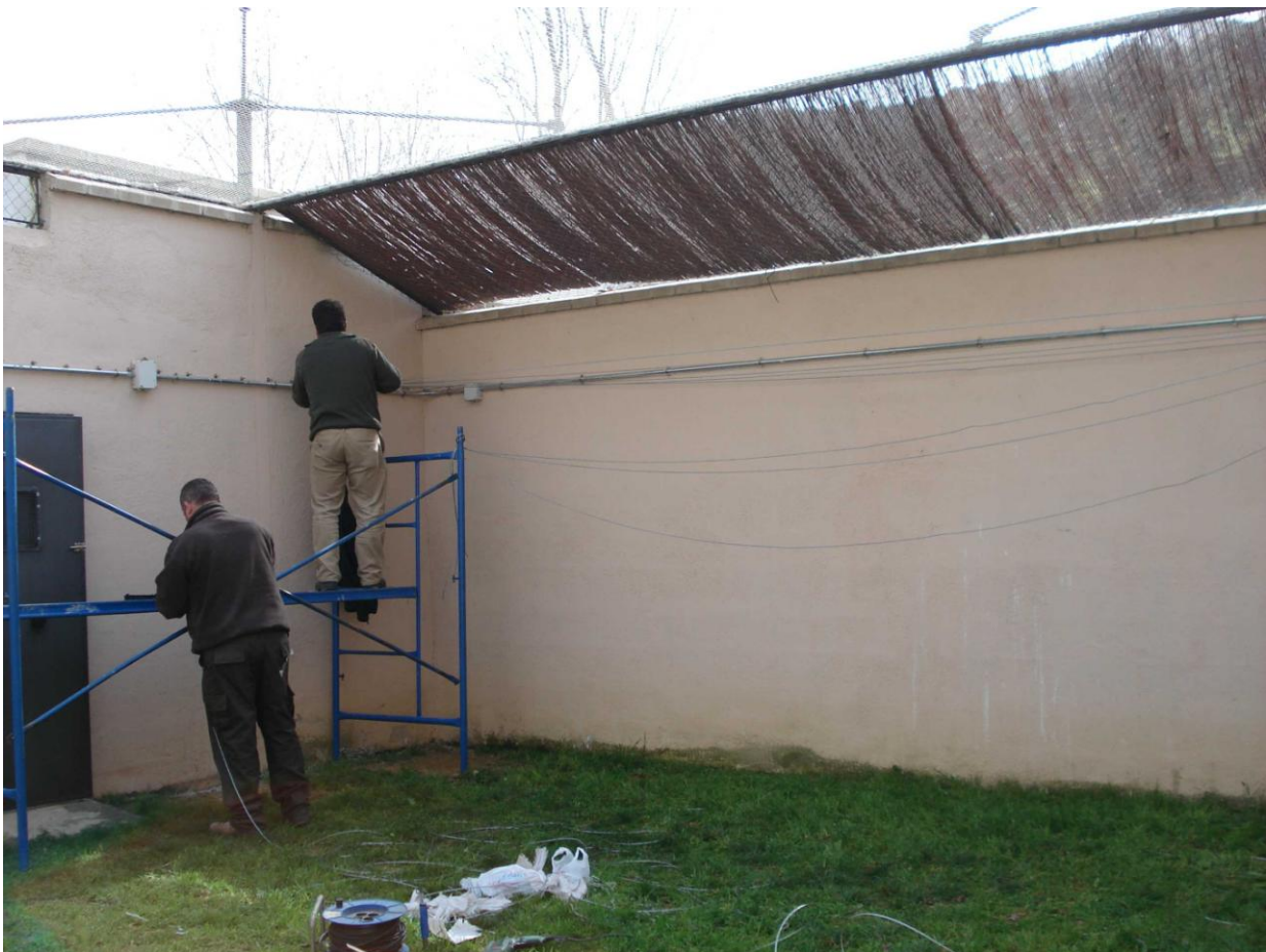
Adecuación de voladero como cuarentena de lince ibérico en el CREA "El Blanqueo". (Foto: El Blanqueo)
